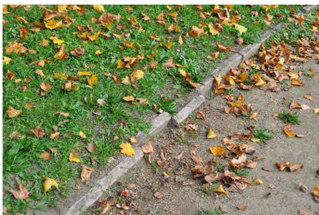
Abb. 215 schadhafte Wegekanten
