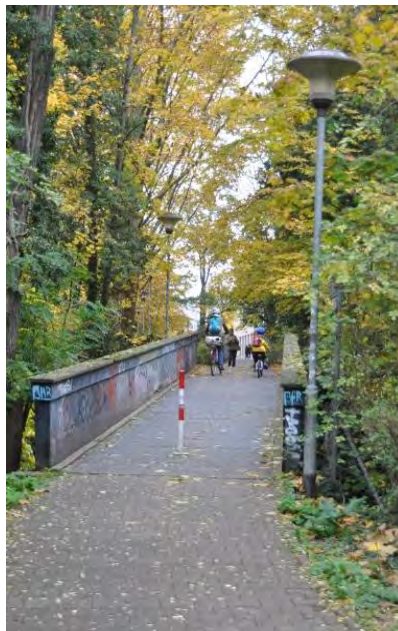
Abb.213 Brücke am Ravelin 2015
