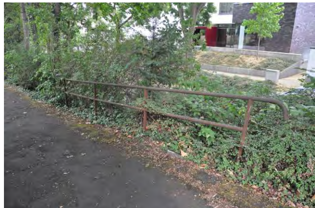
Abb. 71 Geländer oberhalb der Böschung Auf der Steig
