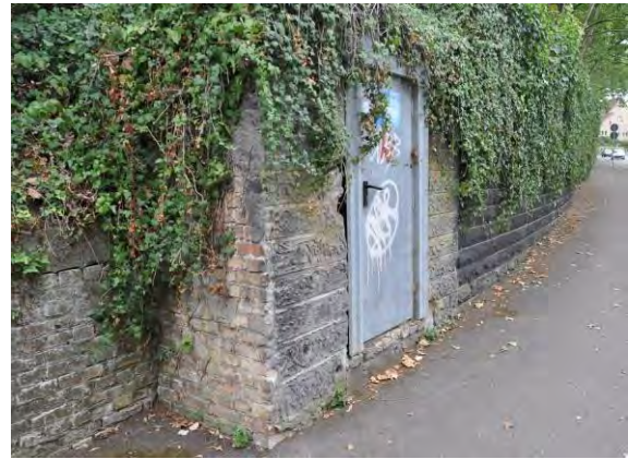
Abb. 65 Mauer Salvatorstraße Nord
