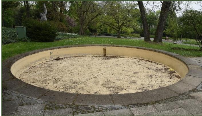
Undichtes Triton-Becken mit Rissen im Beckenboden
